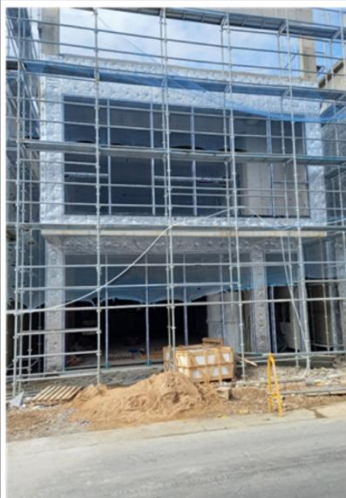
김포시 서암리 근린생활시설 신축
