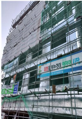
강원도 상가건물 신축 공사
