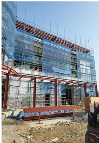
충남 교육시설 신축 공사
